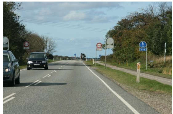
Dobbeltrettet cykelsti langs vej (Lemvigvej)
